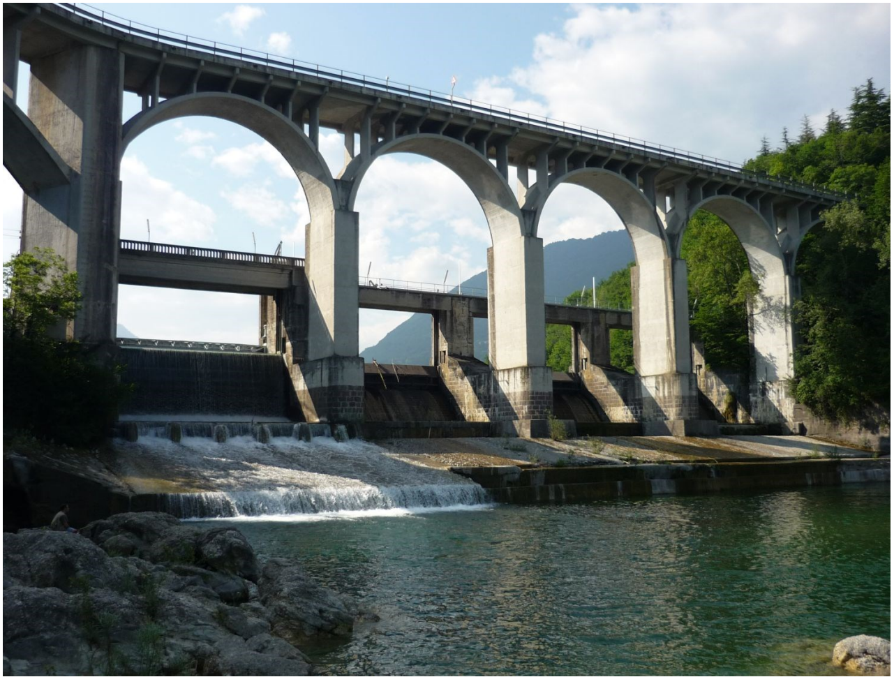
Figura 5.2 – Ponte e traversa di Maraldi vista a valle
